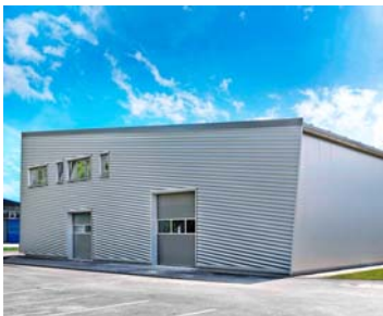
Losberger Pultdach-Halle für neue Filiale von Würth, 100 mm Sandwichelemente in Dach und Wand mit darüberliegender Aluwellen
